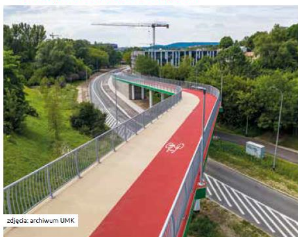
Kładka pieszo-rowerowa w Podgórzu
